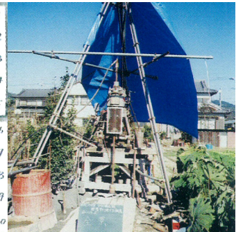
ボーリング作業状況
