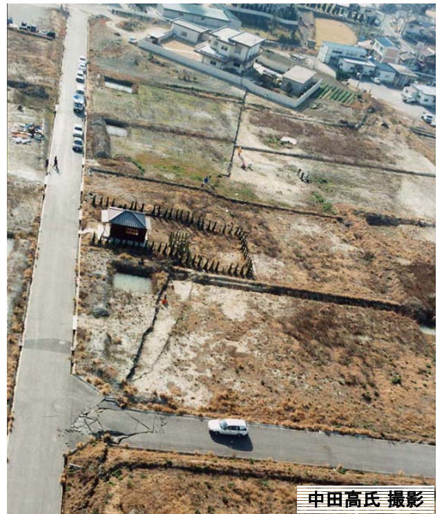
野島断層の変位による被害
